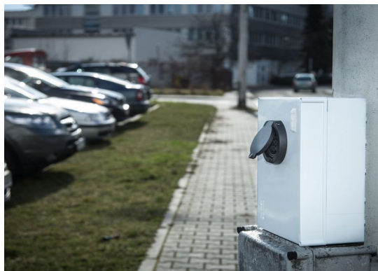
Wallbox může být jen malá krabička se zásuvkou a trochou elektroniky na kraji parkoviště
